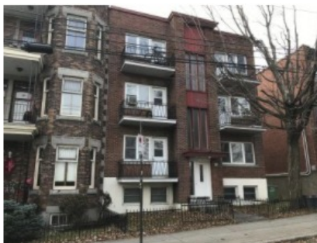
6 logements Construction : 1954 2530 Nicolet, Montréal (Hochelaga- Maisonneuve) Transaction : 2018-05-02, 750 000 $ (125 000 $/log.)
