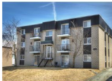
12 logements Construction : 1974 4150 Chauveau, Sherbrooke (Jacques-Cartier) Transaction : 2018-02-07, 894 500 $ (74 542 $/log.)
