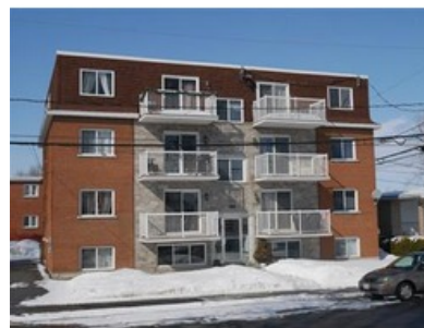
8 logements Construction : 1974 740 Brunette E., St-Hyacinthe (St-Joseph) Transaction : 2018-08-23, 660 000 $ (82 500 $/log.)
