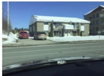
8 logements Construction : 1989 1461 à 1475 Brûlotte, Sherbrooke (Fleurimont) Transaction : 2018-09-07, 600 000 $ (75 000 $/log.)
