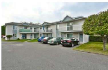
8 logements Construction : 1987 15905 à 15913 Bourdages S., St-Hyacinthe (La Providence) Transaction : 2018-11-21, 666 000 $ (83 250 $/log.)
