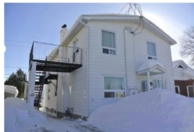
5 logements Construction : 1937 67 Perreault O., Rouyn-Noranda Transaction : 2019-12-17, 425 000 $ (85 000 $/log.)
