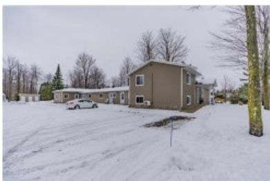
5 logements Construction : 1980 5820 à 5860 5e rang, Saint-Hyacinthe (Ste-Rosalie) Transaction : 2019-07-04, 440 000 $ (88 000 $/log.)
