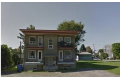
6 logements Construction : 1962 2775 d'Estimauville, Québec (Beauport) Transaction : 2019-11-29, 360 000 $ (60 000 $/log.)
